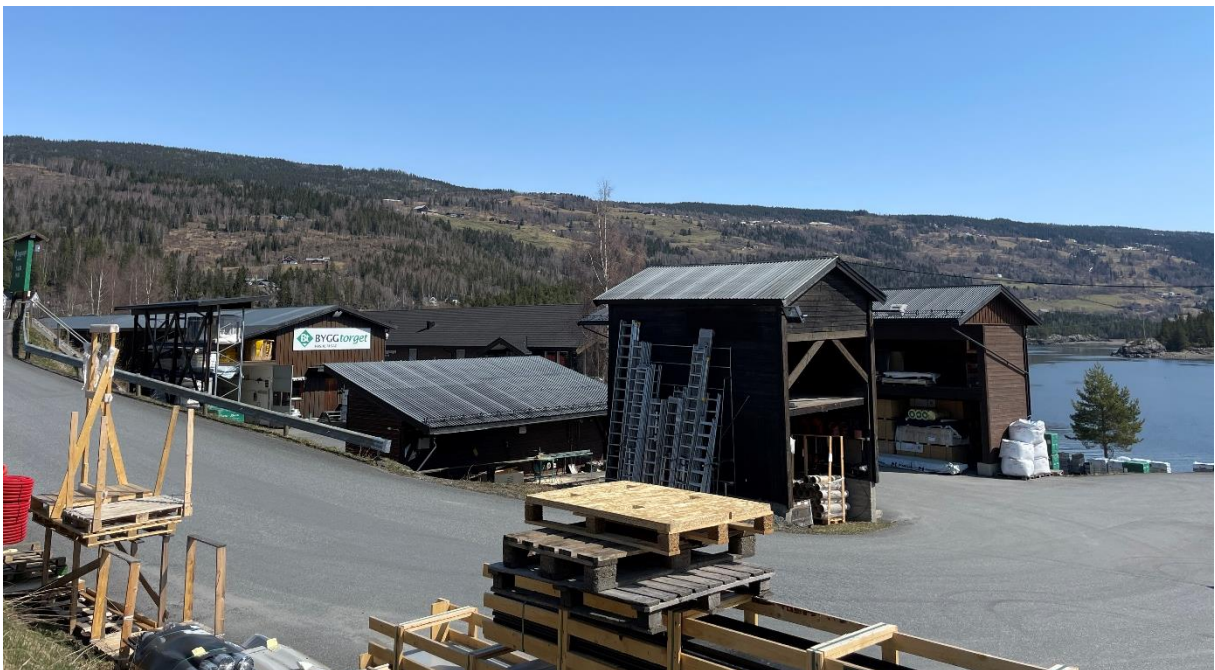
Figur 93. Saga er i dag byggjeverretning
