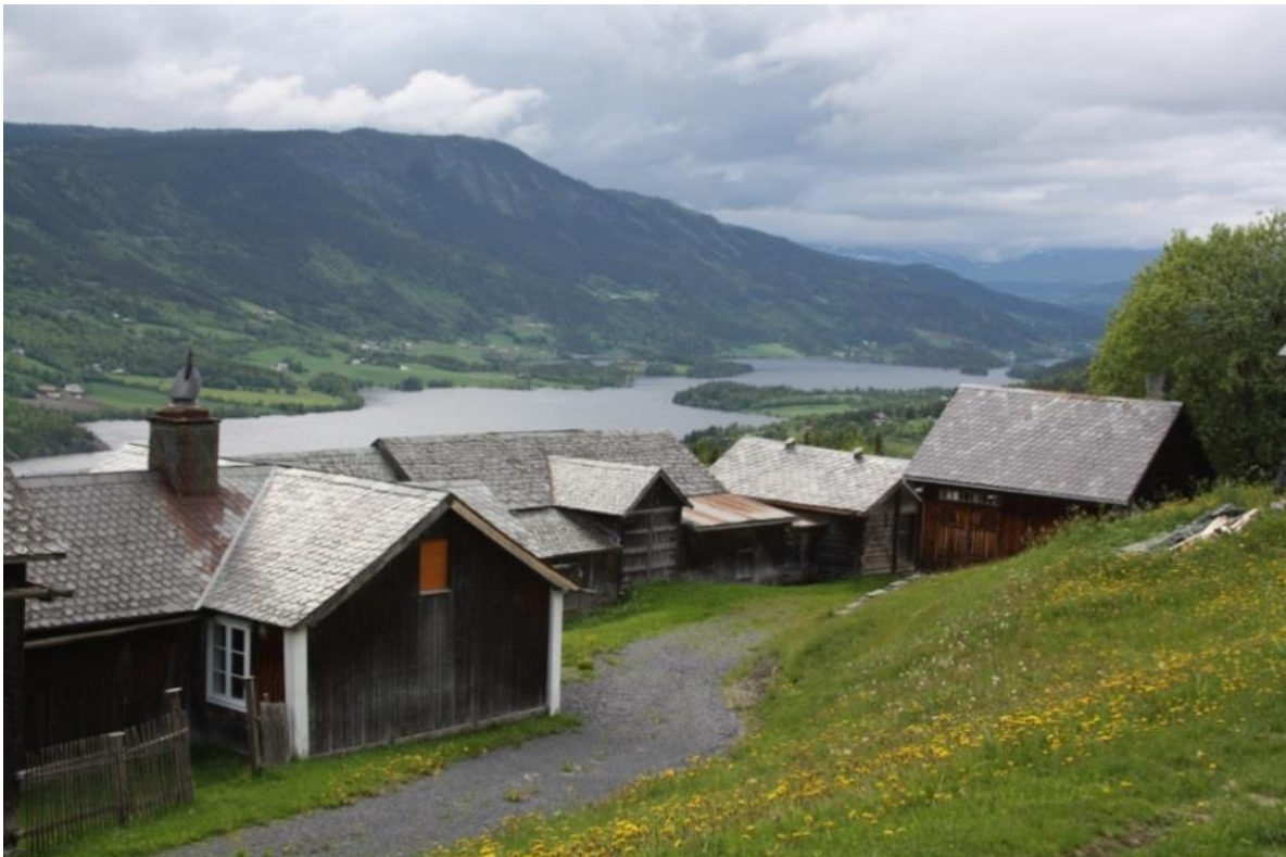
Figur 128. Delar av tunet sett frå aust.
