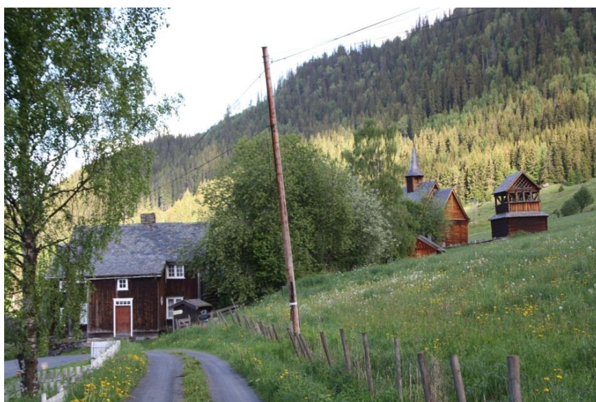
Figur 51. Kyrkja ligg saman med godt vedlikehalde kulturlandskap og bygningar.
