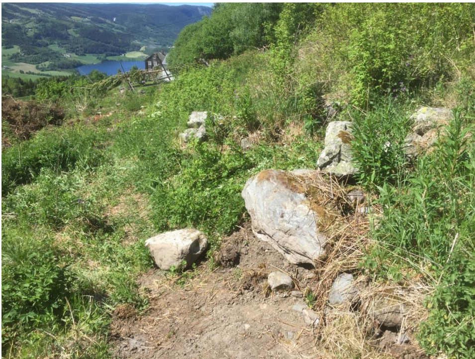
Figur 163. Tufta etter rydding av tre i 2016. Nærmast er hjørnet i koret. Hogstmaskinen har velta to store steinar ut av muren. Til venstre litt bak skimtar vi hjørnet av skipet i kyrkja.
