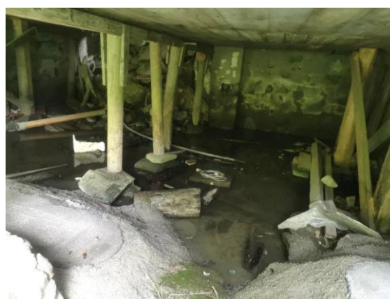
Figur 99. Foss trevarefabrikk. Til høgre: vatn under bygningen med fleir forsøk på strakstiltak for å unngå ras. Foto: privat.
