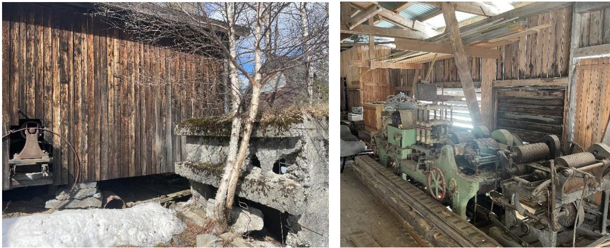
Figur 97. Til venstre: Fossen sag med deler av turbinen til høgre i bilete, to bjørk har funnet rot ved bygningsmassen. Til høgre: Ei nyare sag i støypejern på innsida av bygningen.
