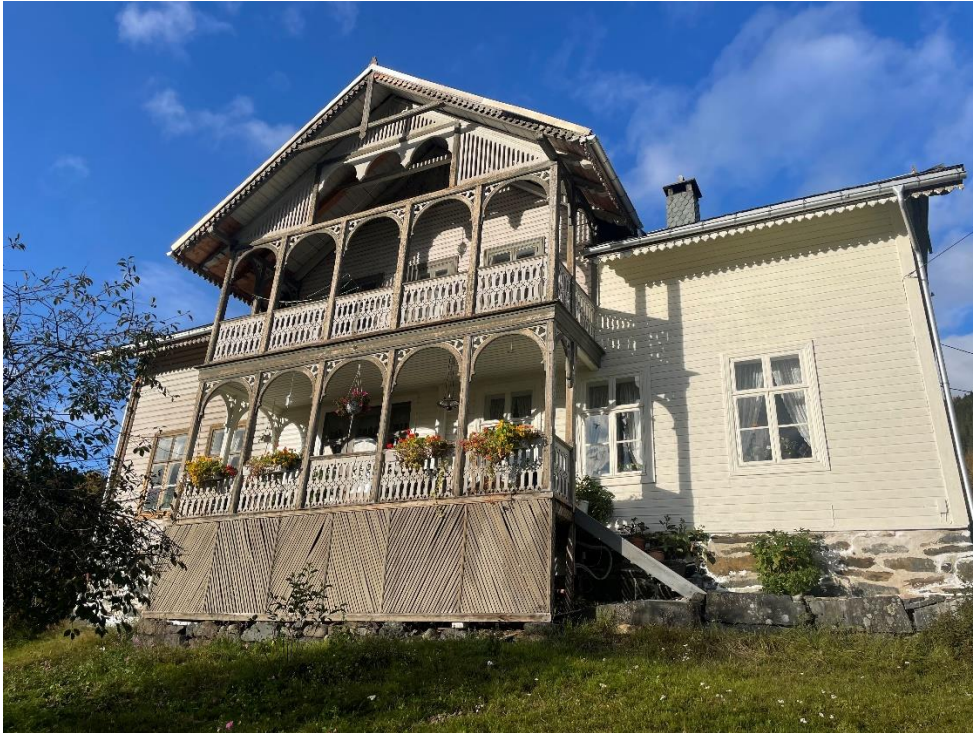
Figur 121. Hovudhuset er bygd i sveitserstil.
