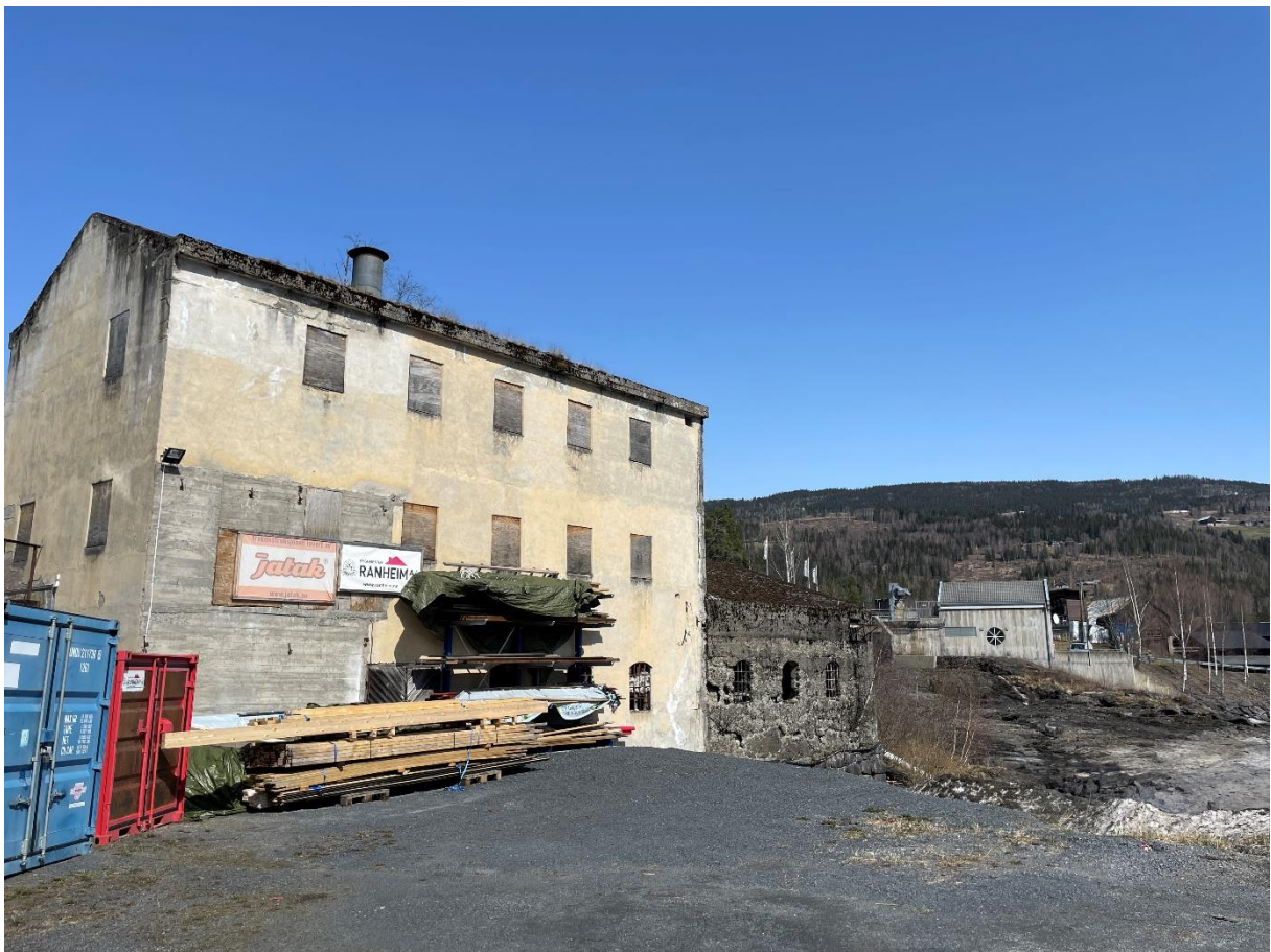
Figur 89. Nedlagt mølle og kraftstasjon.
