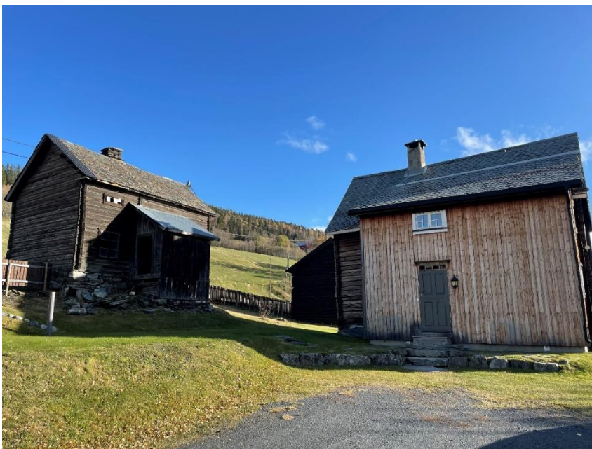
Figur 142. Øvrebygning/kårbustad sett nedanfrå (til venstre i bilete). På kårbustaden er det gjort strakstiltak på murar, tak og innvendig stabilisering. Ein god del vegetasjon er rydda.
