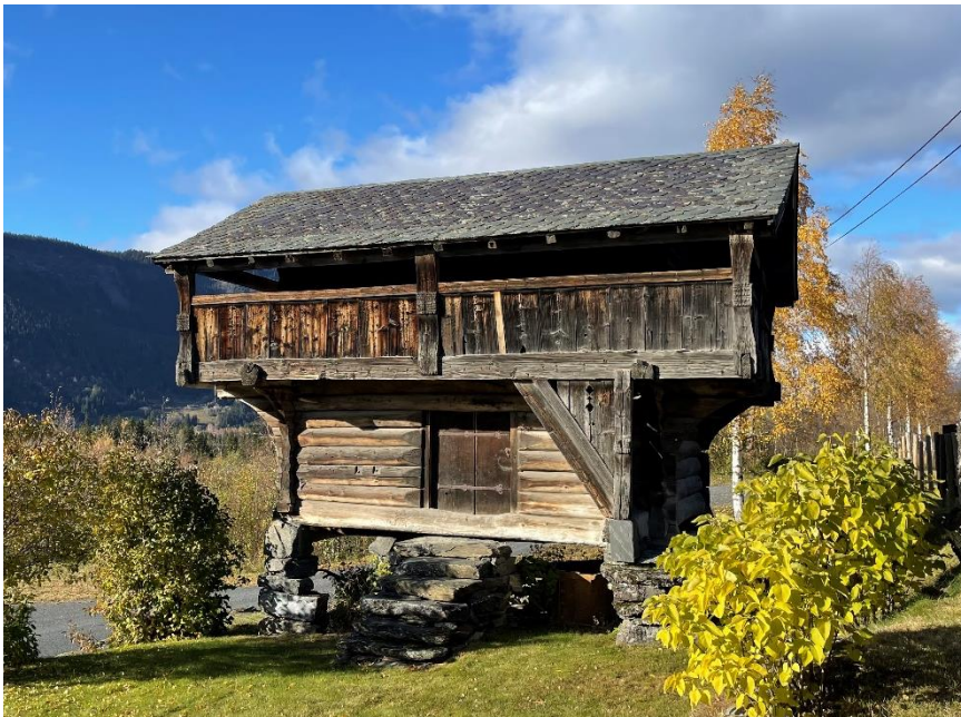
Figur 145. Taktekking, utskifting av treverk, trapp og steinmurar på stabburet er restaurert.
